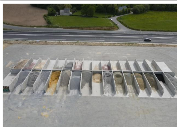
Silo à granulats à Brecey (50)
