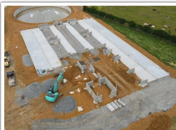
Bâtiment avec robots + fosse à Poillé sur Vègre (72)
