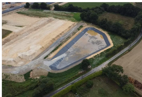
La Gravelle (53) – Réserve incendie de 8 500 m 3 pour un site industriel
